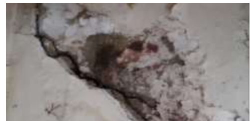
Fotografía 7. Detalle del desarrollo de microorganismos (hongos y bacterias en el inmueble)
