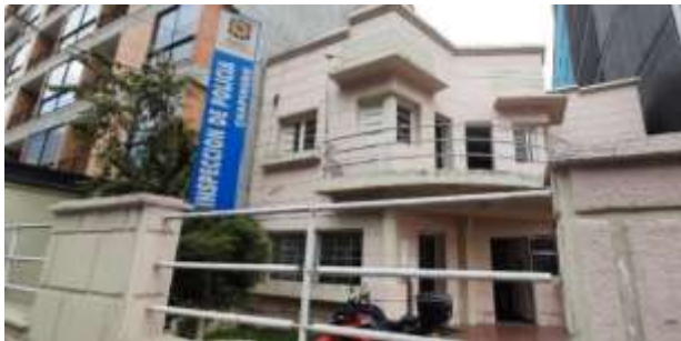
Fotografía 3 Fachada del edificio.
