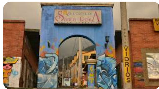
Nombre: Pórtico que da entrada al barrio Santa Rosa Fuente: Colectivo Artoarte. Fredy Triana Vargas. 2015
